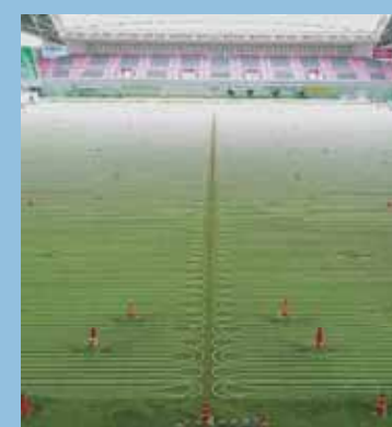
ソルコン施工状況
