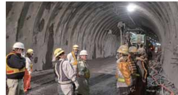
東北支店 三枚堂トンネル作業所安全パトロール
