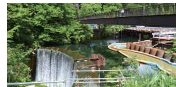
施工状況(左が現在の堰堤、右上が希望大橋)
