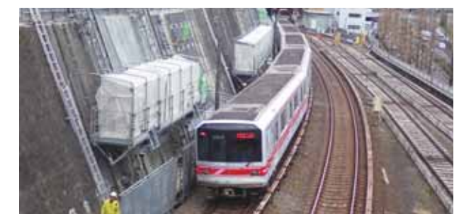
狭隘部での施工状況
