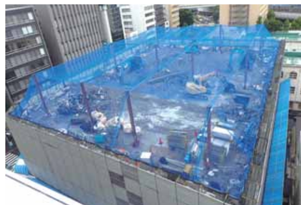
1フロア解体と同時に屋根ネットも下降
