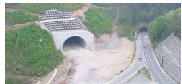
左が竣工した気仙沼第2号トンネル
