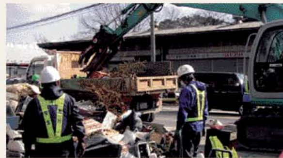
がれき撤去の様子
