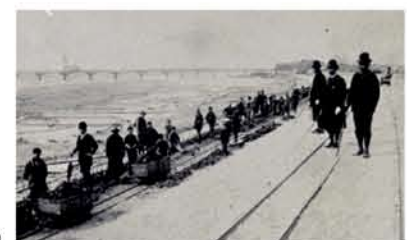
常願寺川改修工事(明治25年)
