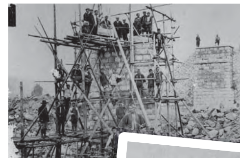
中央線中津川工事
