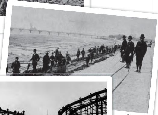
常願寺川改修工事
