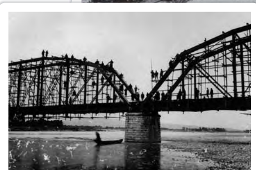
北陸線庄川鉄橋工事
