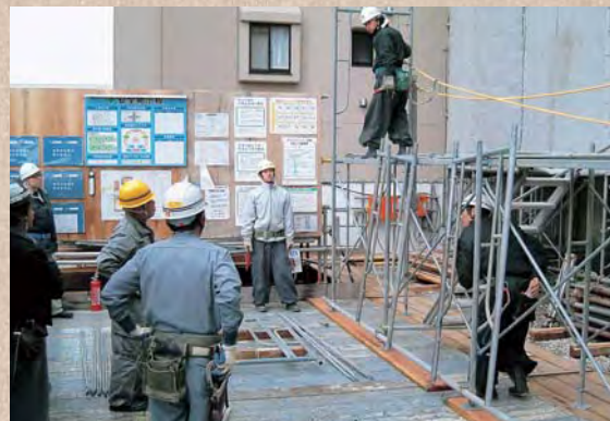
足場組立実習
