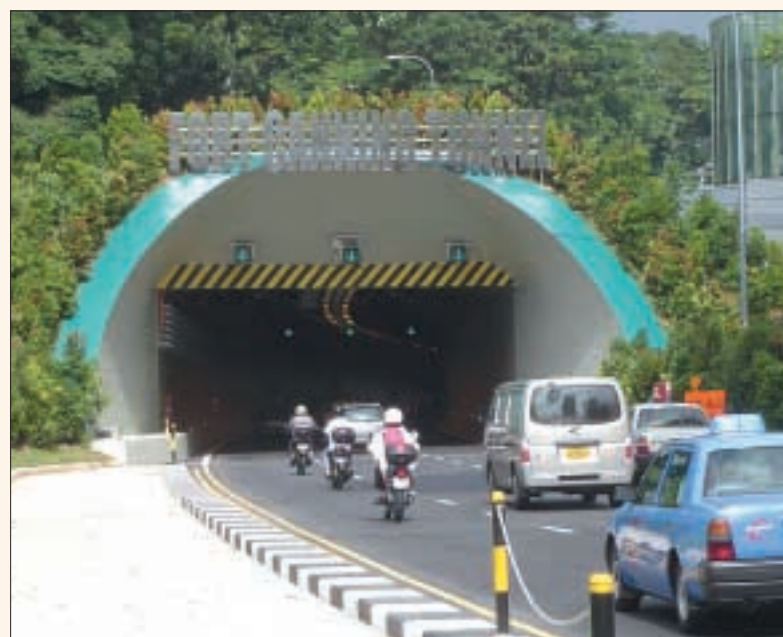
完成したフォートカニングトンネル
