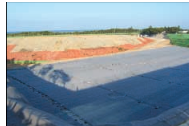
再生工事状況(底盤シート敷設:半面)
