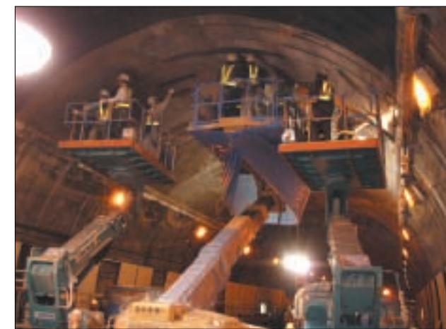
炭素繊維で補強を行った米山トンネル
