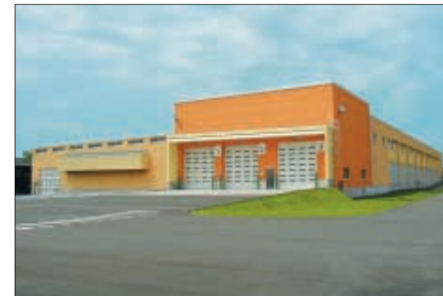
石狩資源循環モデルセンター外観
