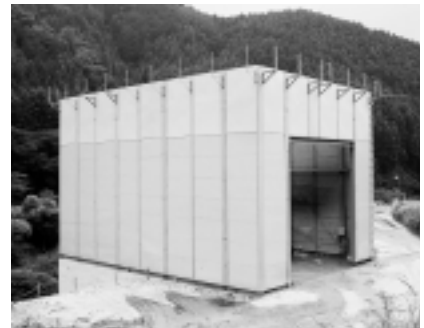
仮置場と防音壁
