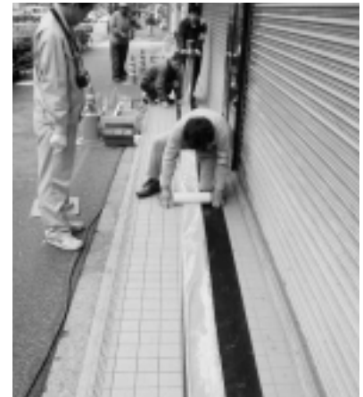
特殊クロスにエポキシ樹脂を浸透
