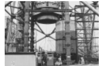
台車にのせて切断した煙突を引き出します
