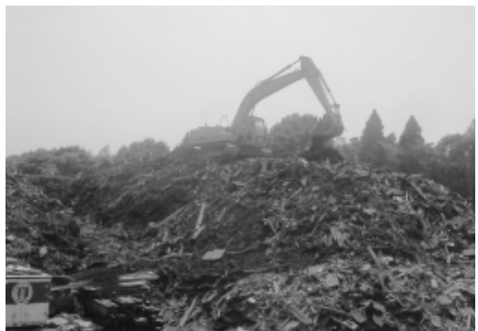
チップの掘削・撤去
