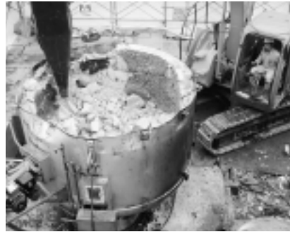
重機による解体
