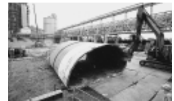
引き出した煙突を地上で解体します
