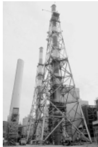
J-POWER/電源開発 礪子火力発電所
