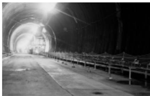
清浄な環境を維持している坑内とベルトコンベヤ
