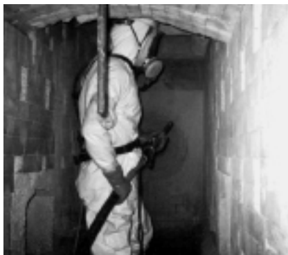
施設内部での解体作業
