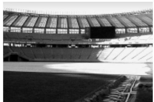
味の素スタジアムでの施工事例
