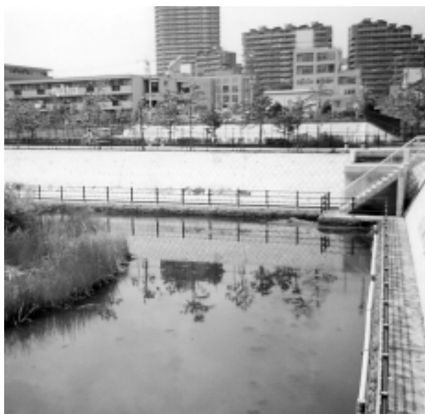
調整池内全景 / 池底部の水位は地下湧水によって一定に保たれています。また、池中央に盛土をして島を設けています。
