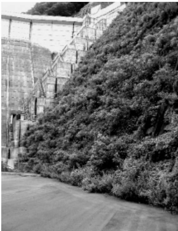
階段植生工による緑化状況(施工5年目)
