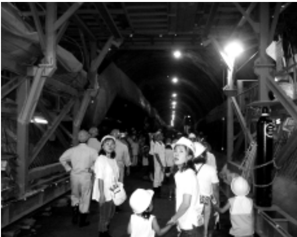
トンネル坑内の見学(高知県:新宇治川トンネル作業所)
