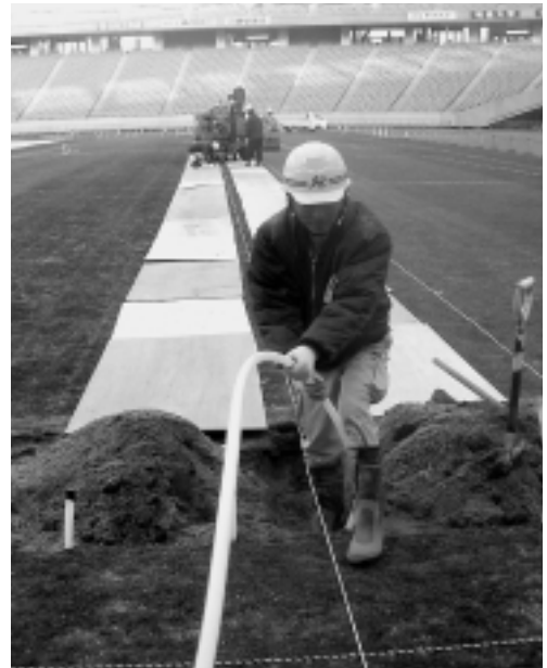
芝生を生かしたまま温水配管を設置
