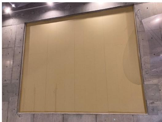
写真-2 せっこうボード壁施工状況
